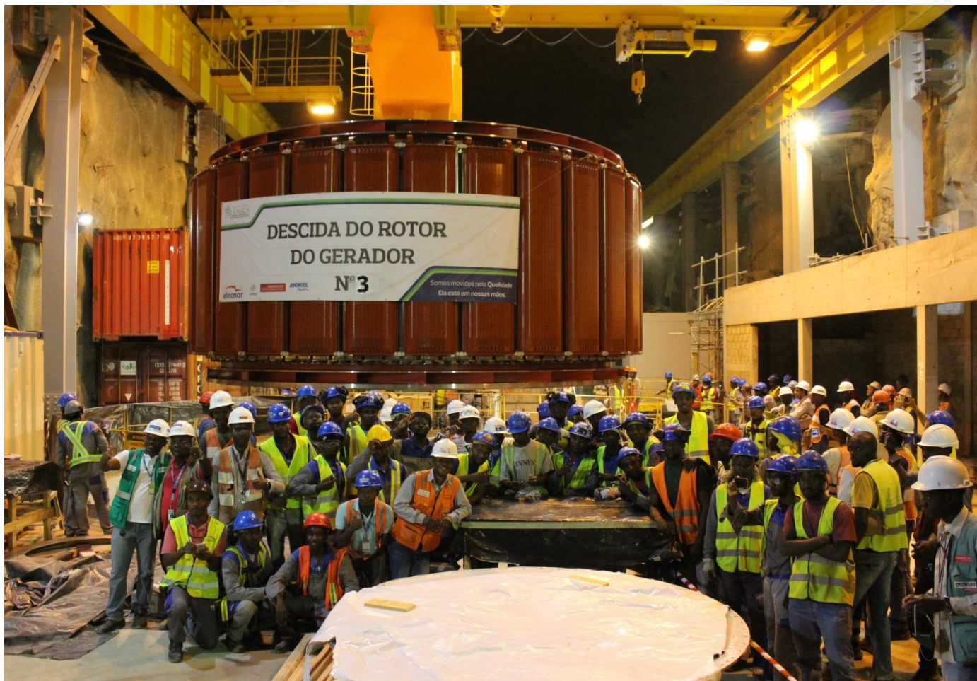
Equipa de Laúca durante a descida do rotor da unidade 3
